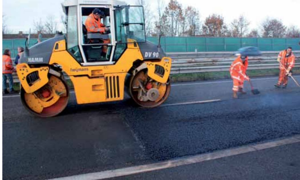
Op de A58 bij Vlissingen ligt een strook van vierhonderd meter zelfhelend asfalt.
